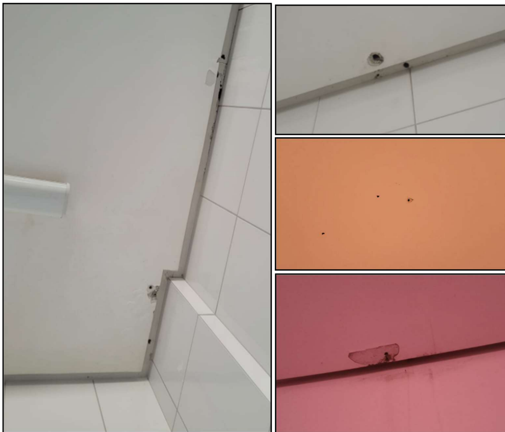
Foto 03. Vazamento das tubulações superiores
