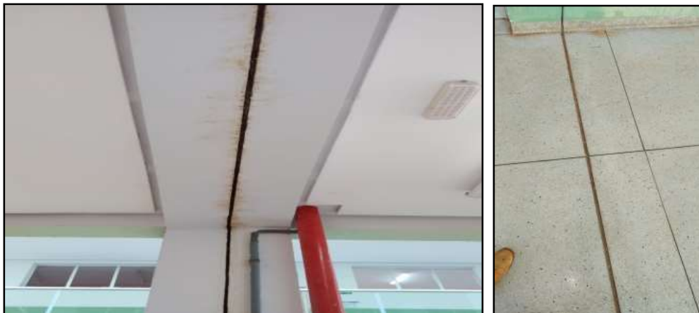
Foto 19. Juntas de dilatação
