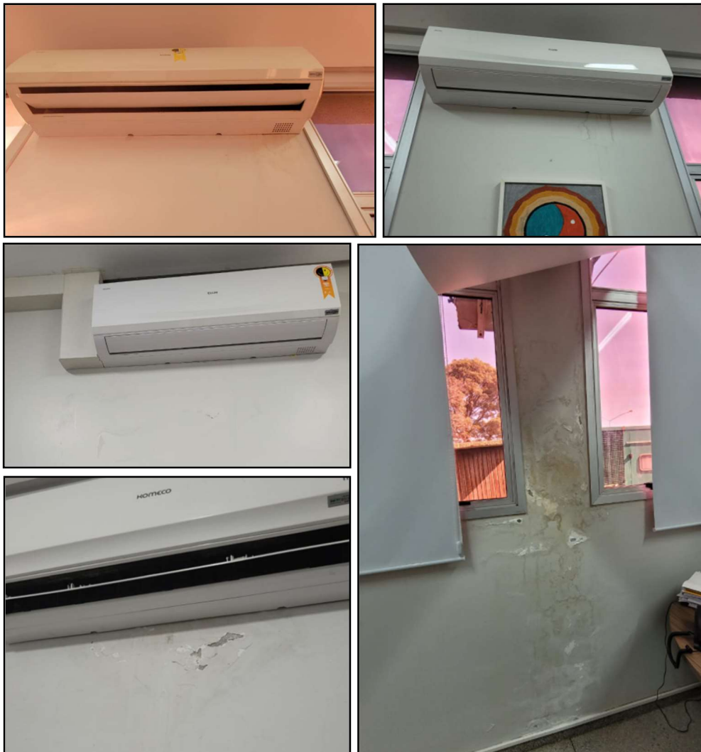
Foto 02. Salas com vazamento em dreno
