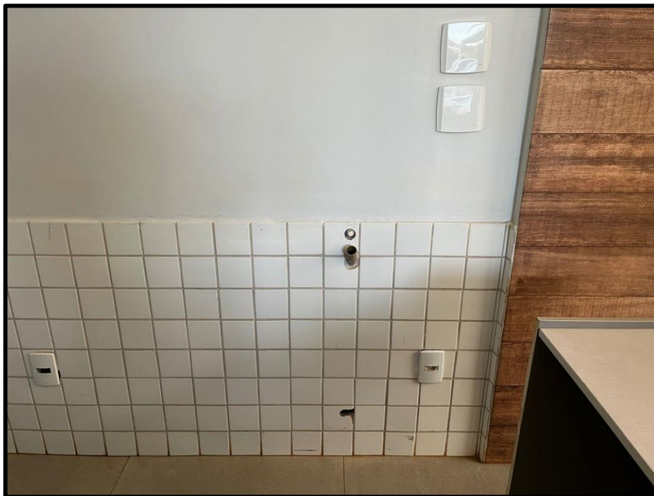
Foto 05 – Ponto de água e esgoto no ambiente Circulação.
