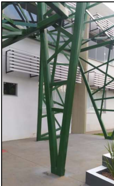
Figura 4. Local de descida do condutor vertical (sistema pluvial).
