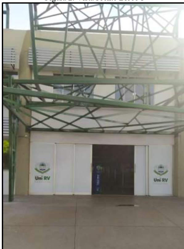
Figura 2. Vista Frente Bloco I
