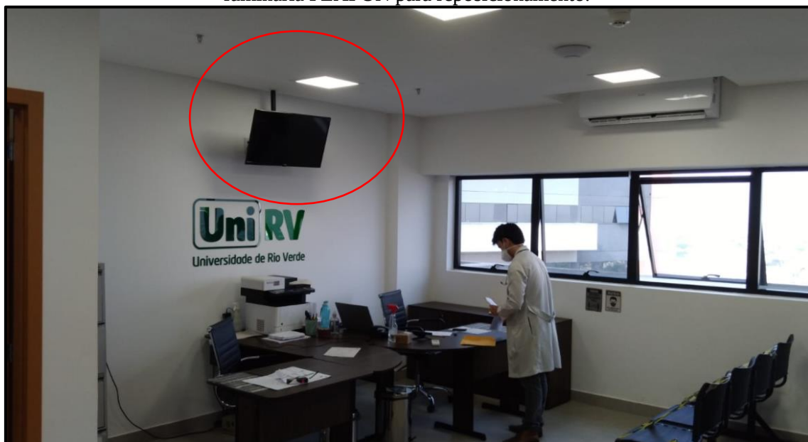
Figura 4. Recepção (Décimo Oitavo Andar) – Local em que serão executados os novos banheiros acessíveis. Deverá ser realizada a remoção das instalações elétricas da telefonia e luminária PLAFON para reposicionamento.
