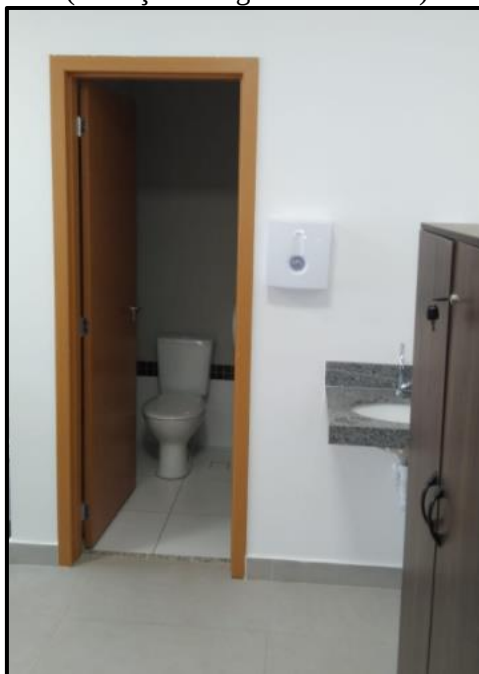
Figura 9. Sala 1702 (Décimo Oitavo Andar). Deverá ser realizada a retirada da porta para reaproveitamento (a ser entregue para CONTRATANTE) e fechamento com gesso acartonado. (Serviço análogo na sala 1703)
