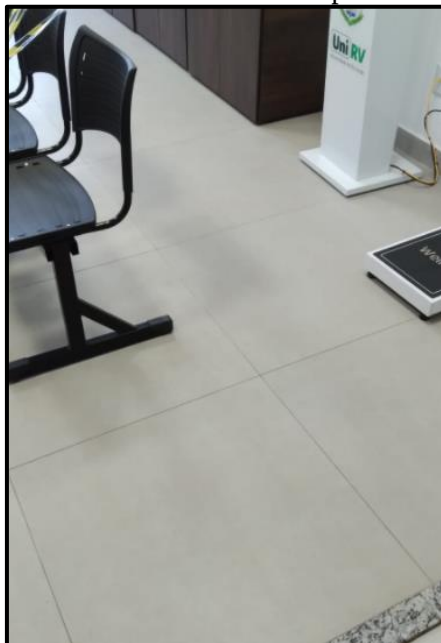
Figura 3. Recepção (Décimo Oitavo Andar) – Revestimento de piso em porcelanato. Deverá ser utilizado no barrado dos novos banheiros acessíveis piso em porcelanato com especificações semelhantes ao do revestimento de piso da recepção.
