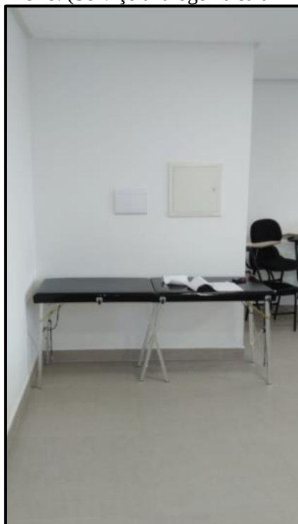
Figura 8. Sala 1702 (Décimo Oitavo Andar). Parede que deverá ser demolida para ampliação do banheiro. (Serviço análogo na sala 1703)
