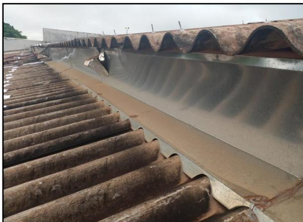
Figura 4, 5 e 6. Perfis metálicos a serem reforçados (terças da cobertura).
