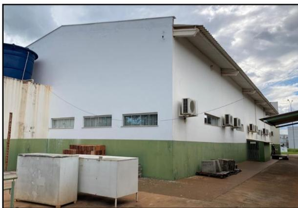
Figura 2. Fachada lateral esquerda: cobertura de telha fibrocimento que deverá ser removida para reforço da estrutura metálica e troca de telhas.
