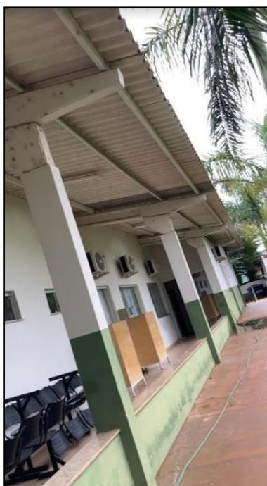
Figura 3. Rufo a ser removido juntamente com as telhas.
