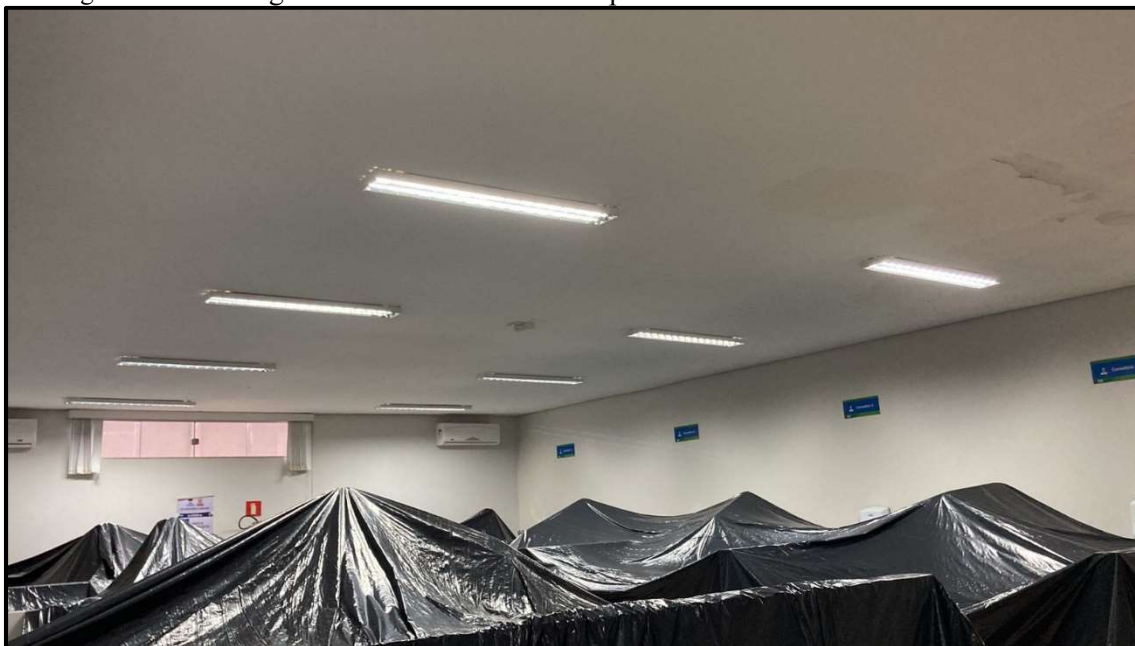
Figura 9. Forro de gesso acartonado danificado pela chuva a ser substituído no BOX 02.
