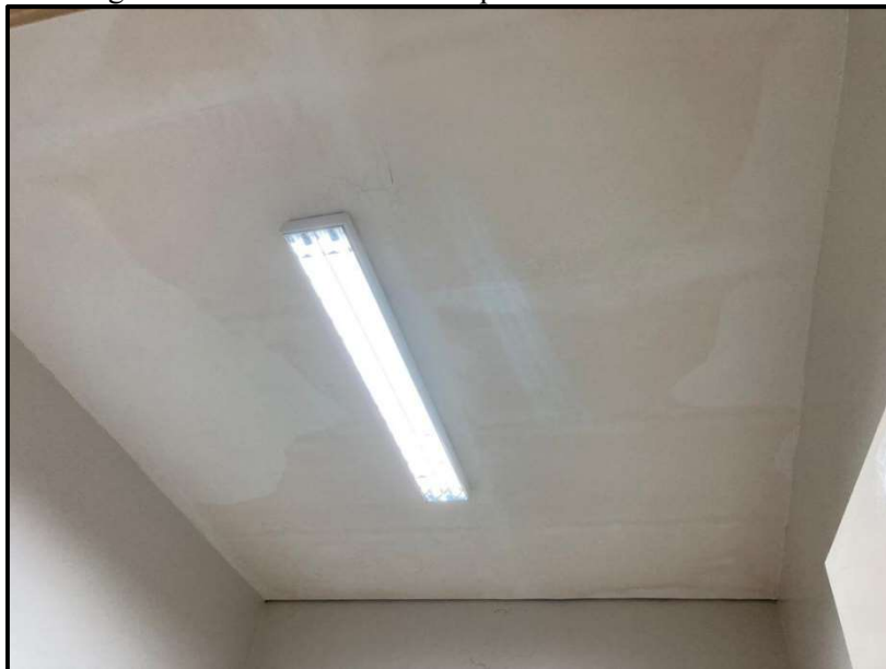
Figura 13. Forro de gesso acartonado danificado pela chuva a ser substituído na sala de PRÓTESE.
