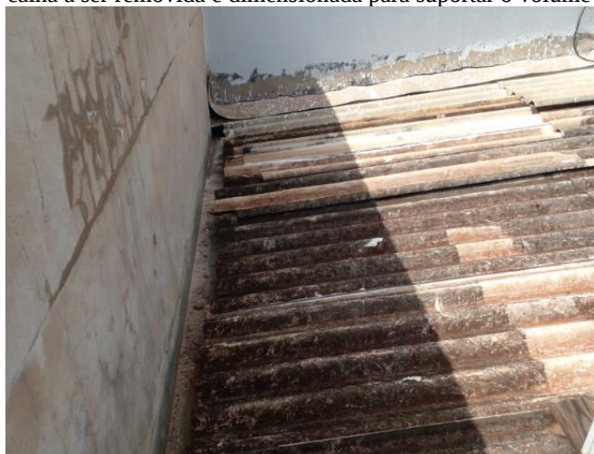
Figura 7. Sistema de calha a ser removida e dimensionada para suportar o volume de água pluvial atual.
