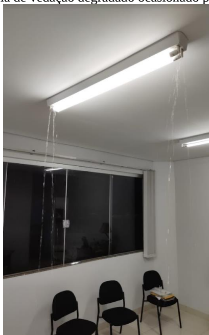
Figura 4. Sistema de vedação degradado ocasionado por chuvas fortes.
