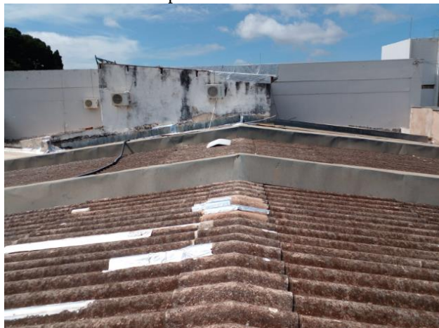
Figura 7. Sistema de calha a ser removida e dimensionada para suportar o volume de água pluvial atual.
