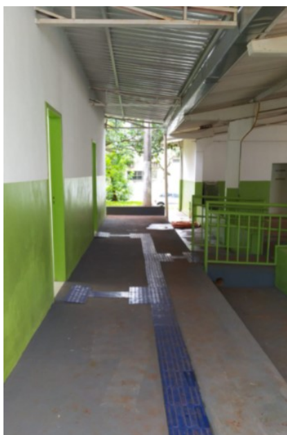
Foto 03. ÁREA EXTERNA BLOCO (LATERAL ESQUERDA)
