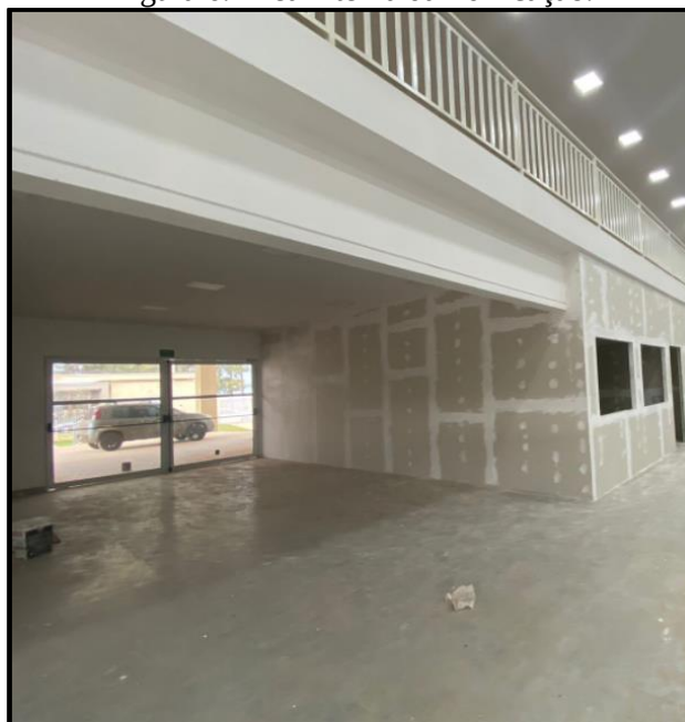
Figura 6. Área interna da Edificação.
