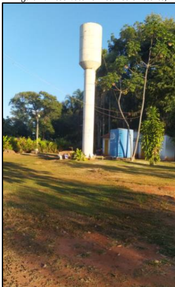
Figura 1. Reservatório metálico existente;
