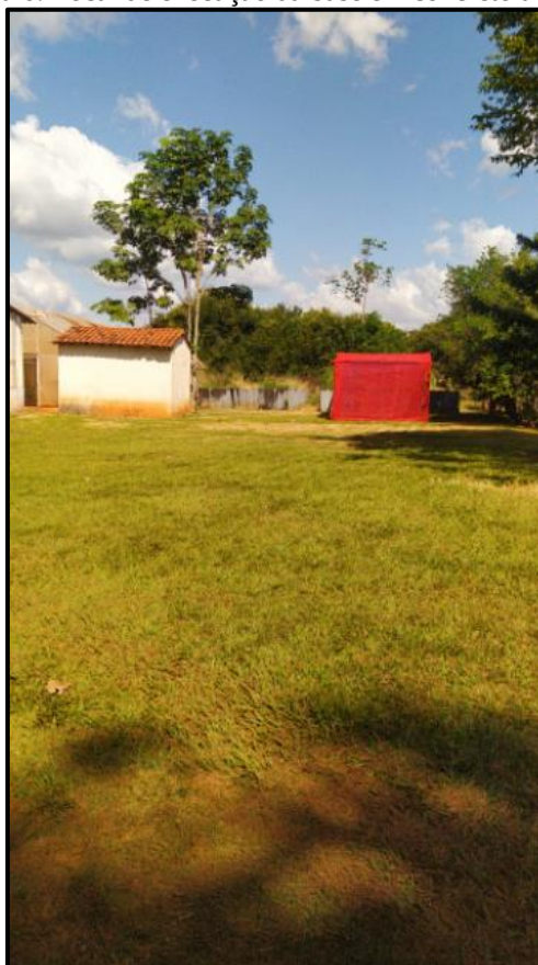
Figura 6. Local de execução da base em concreto armado.
