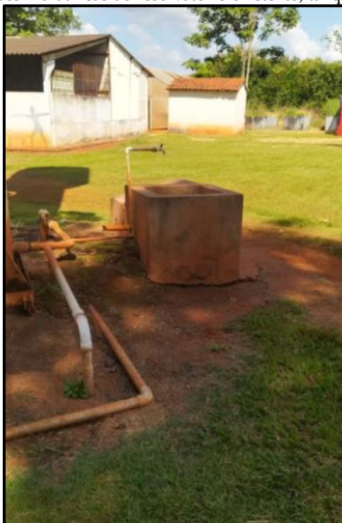
Figura 5. Instalações hidráulicas do reservatório existente; tanque a ser reformado.
