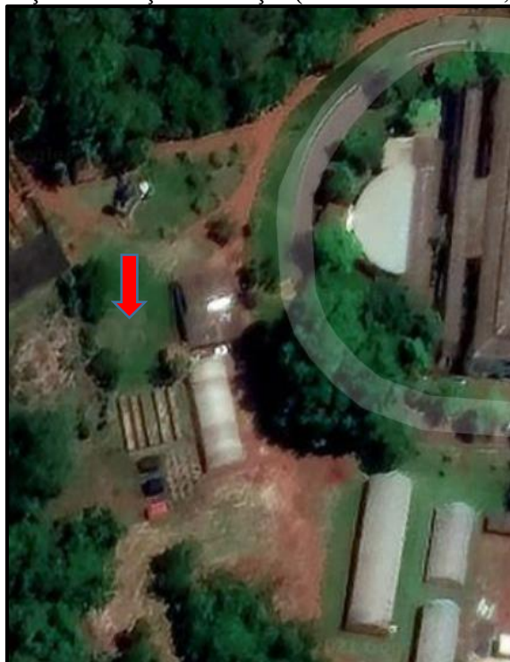
Figura 7. Local de realização do serviço de fundação (latitude = -17.78694 ; longitude = -55,93194)
