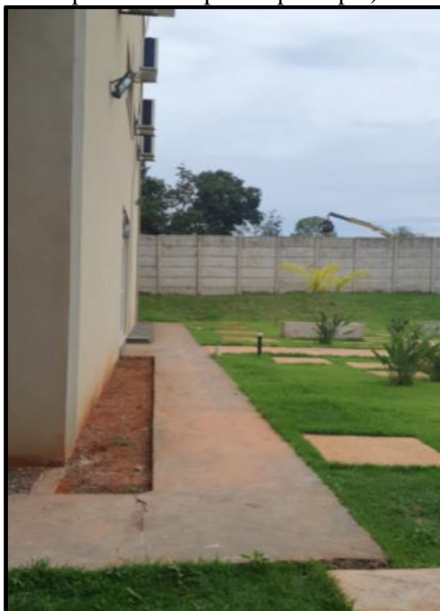
Figura 5. Área externa do Prédio da UniRV – Campus Formosa (detalhe canteiros da região posterior do prédio principal)
