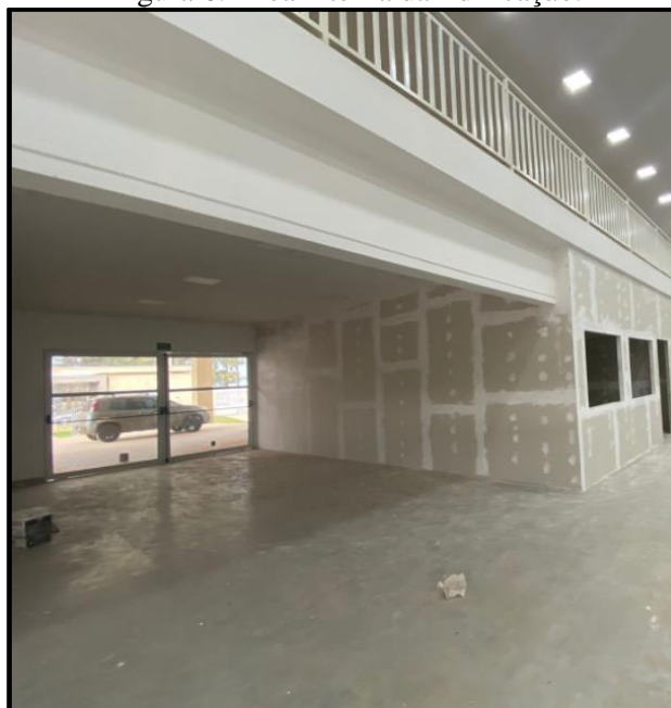
Figura 6. Área interna da Edificação.
