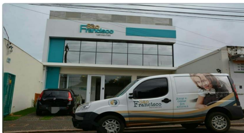
FIGURA 1 - Fachada da Clínica Veterinária São Francisco VetCenter, em Rio Verde – GO.
