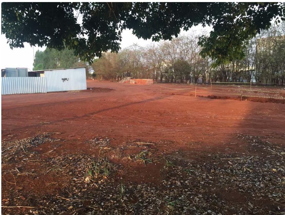
Foto 5. Estacionamento dos blocos 5 e 6.
