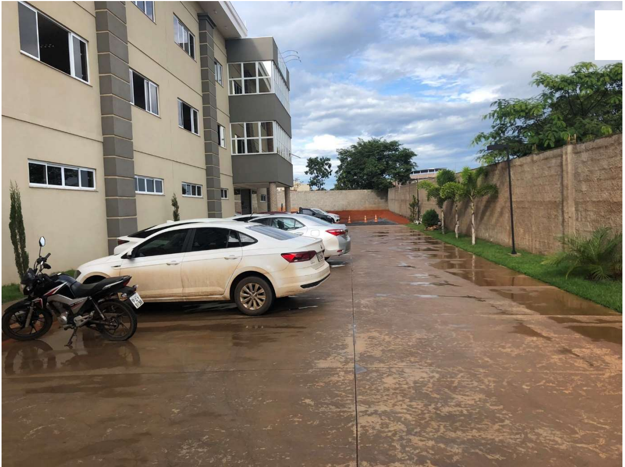
Figura 1 – Fachada do prédio a ser ampliado.
