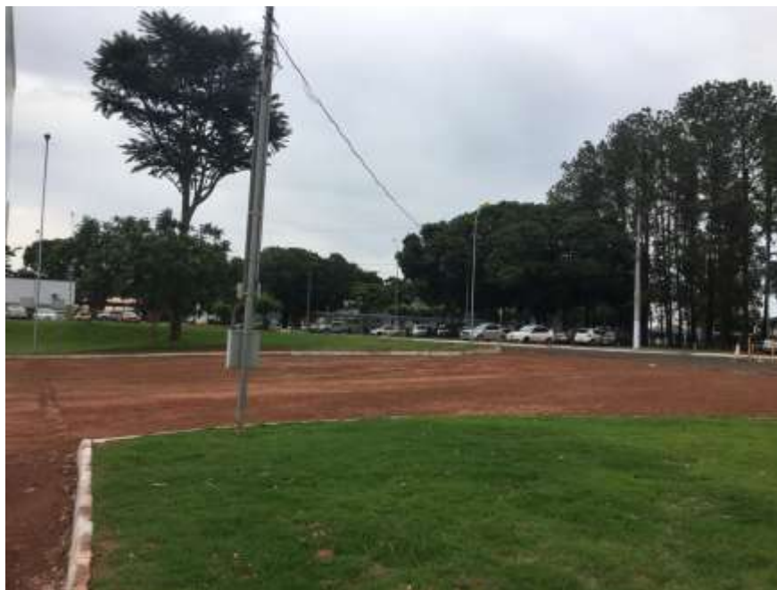
Figura 3 – Local onde será colocado o Poste 1.
