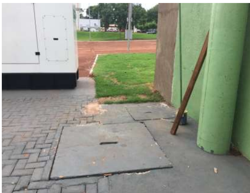
Figura 2 – Caixa de passagem existente II.
