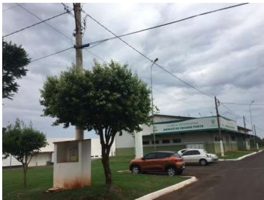
Figura 8 – Postes 3 e 4 existentes.
