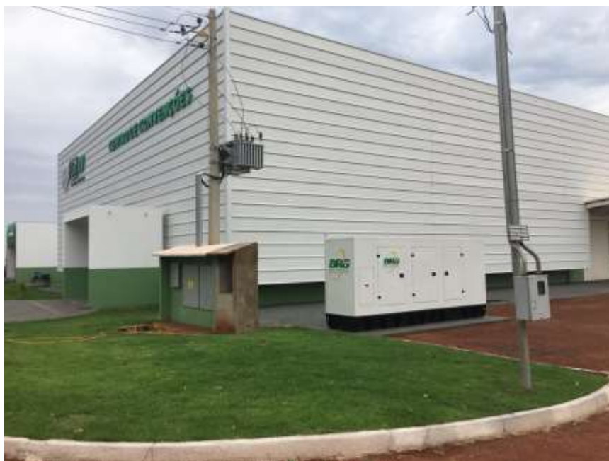
Figura 4 – Local de instalação do poste
