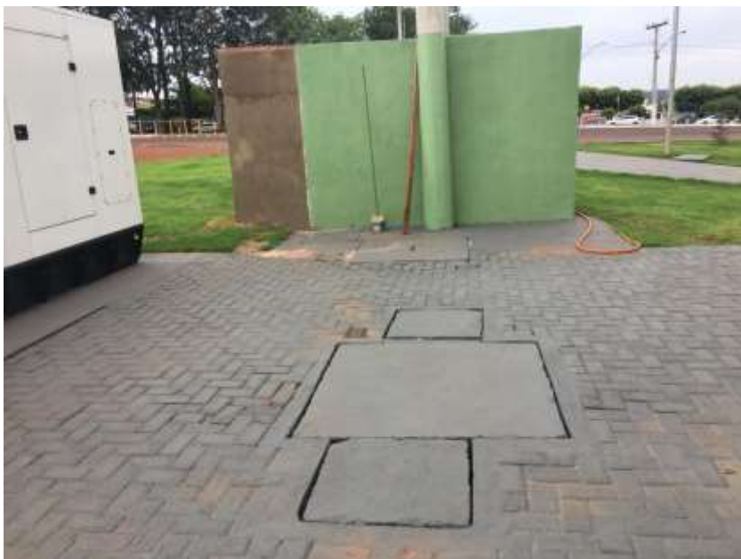
Figura 1 – Caixas de passagem existente I
