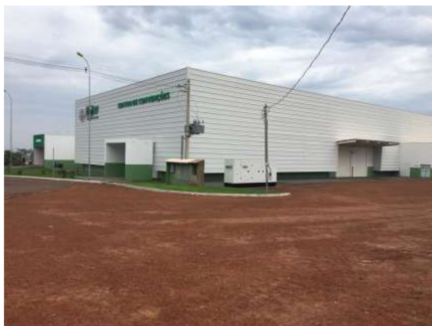
Figura 6 – Local de instalação da extensão de rede – Centro de convenções.
