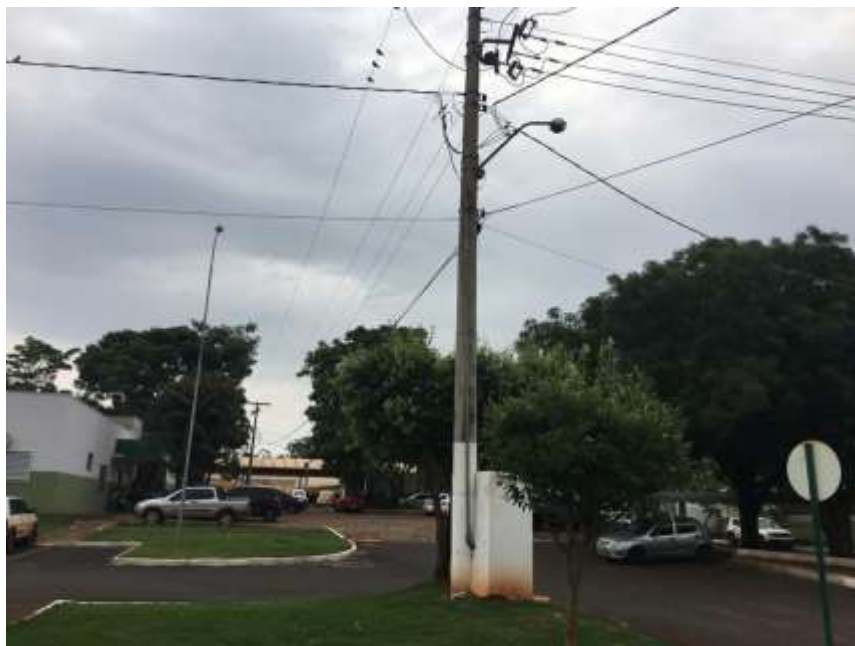
Figura 7 – Poste 3 – poste circular existente.
